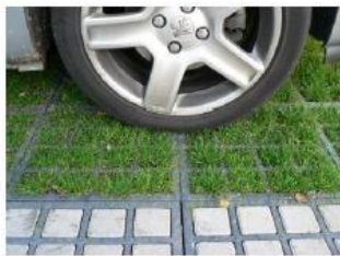
Dalle alvéolaire (béton ou plastique) - Source : Sol-aire
